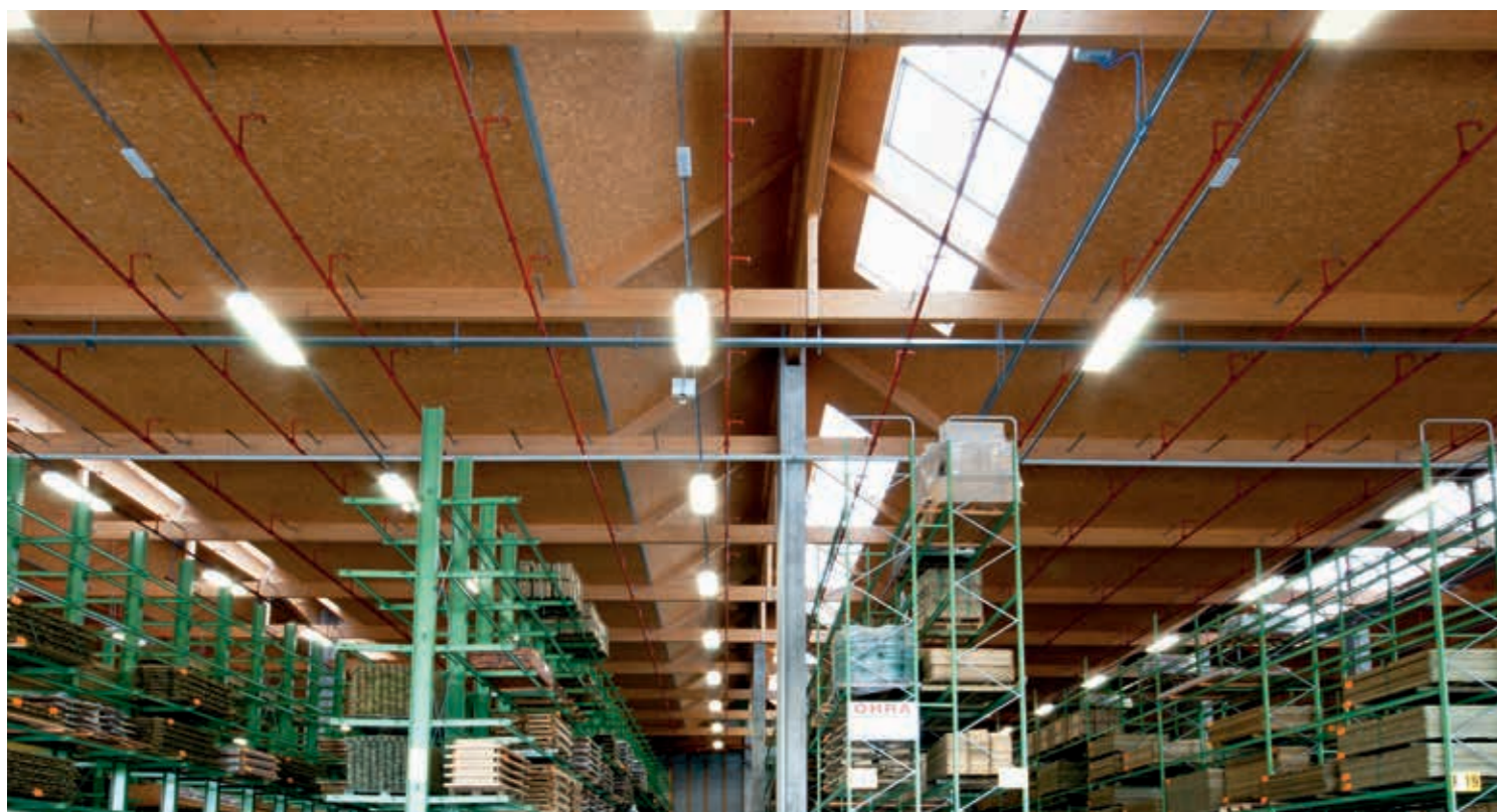
Budynek przemysłowy Pircher Oberland AG, Rolo (I) Projekt: Arch. Erich Oberlechner 810 m 2 konstrukcja z drewna klejonego 10.900 m 2 elementów dachowych 4.900 m 2 fasady www.pircher.eu
