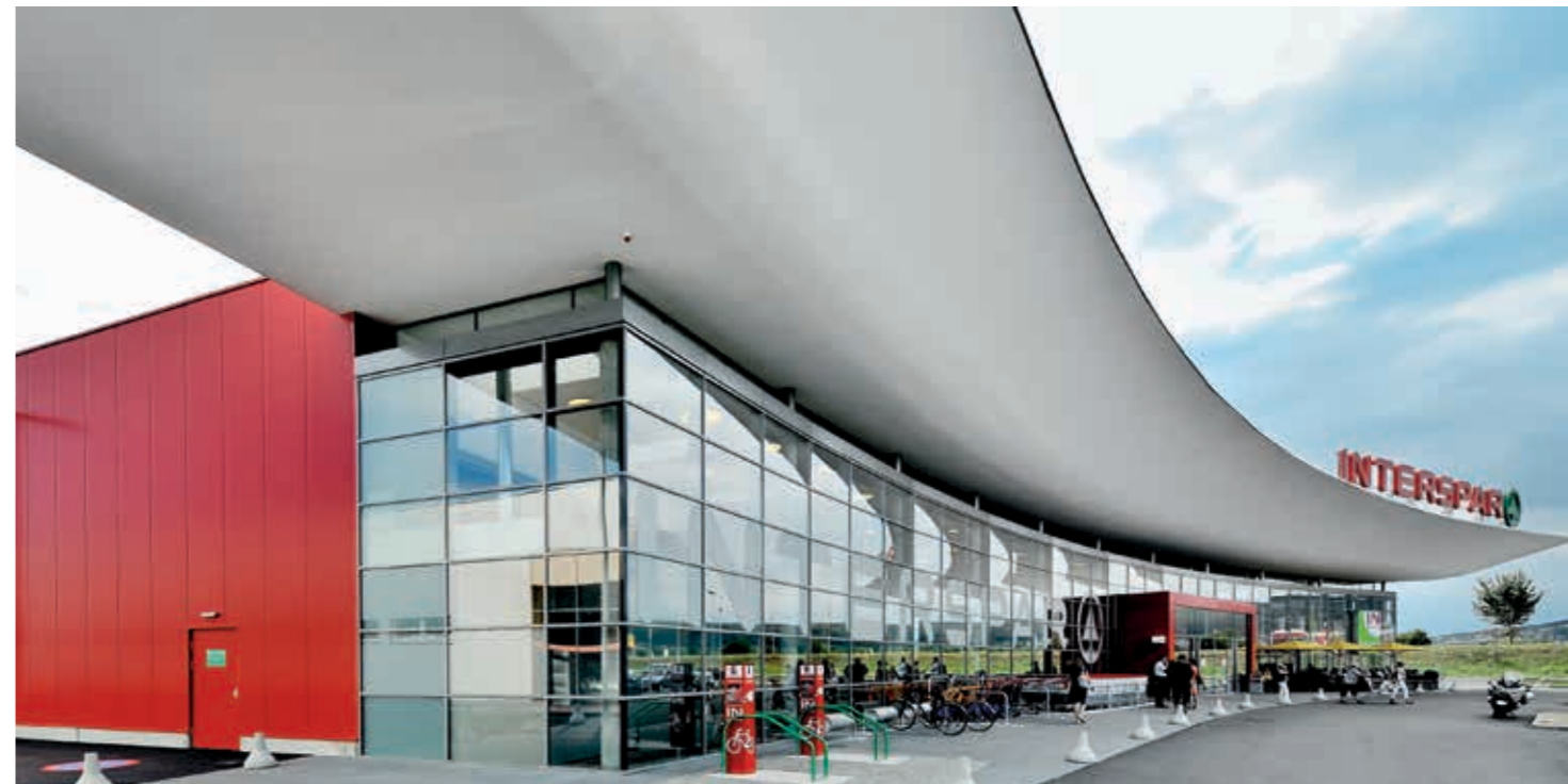
Interspar, Eisenstadt (A) Projekt: Architektur Consult ZT GmbH, Graz 330 m 2 konstrukcja z drewna klejonego 5.500 m 2 elementów dachowych 3.800 m 2 elementów ściennych
