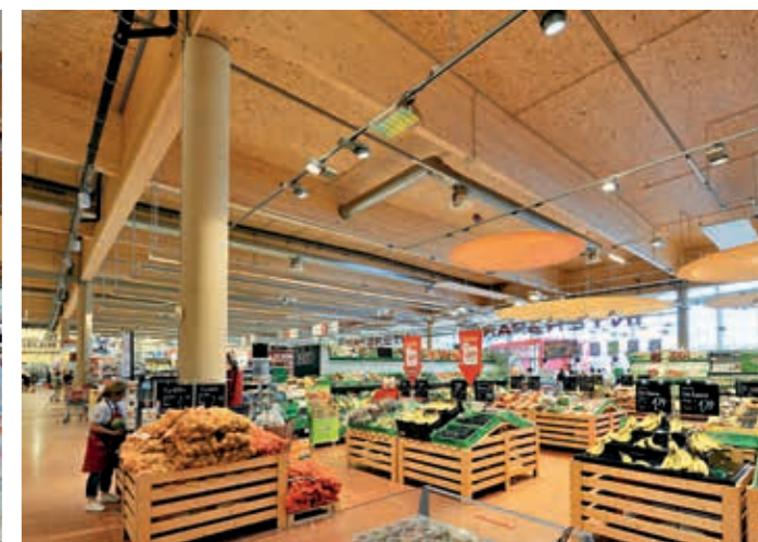
Interspar, Eisenstadt (A) Projekt: Architektur Consult ZT GmbH, Graz 330 m 2 konstrukcja z drewna klejonego 5.500 m 2 elementów dachowych 3.800 m 2 elementów ściennych
