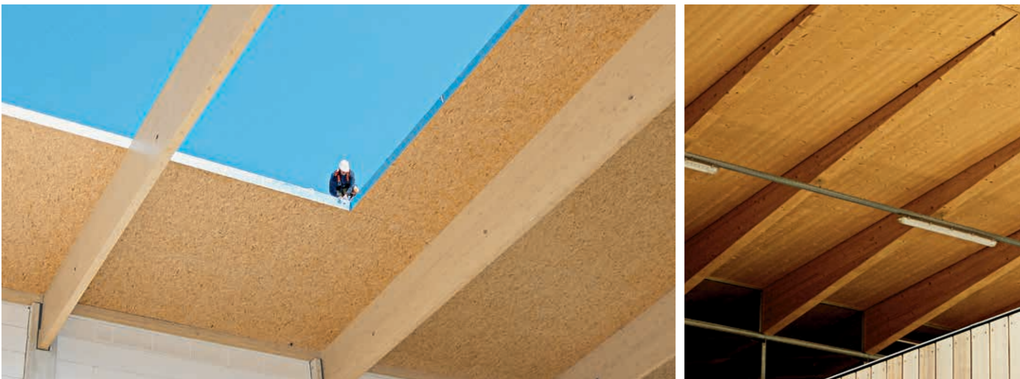
Blacha trapezowa | Podbitka z deski fazowanej | Podbitka z deski fazowanej malowana lazurem | Naturalna płyta OSB | Płyta trójwarstwowa 3s z drewna litego świerkowego
