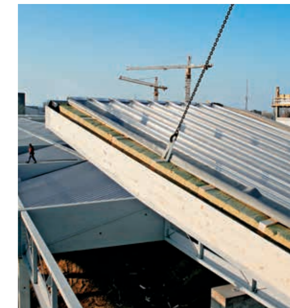
Styk montażowy elementów | Element dachowy z profilowaną blachą aluminiową zamontowaną w fabryce
